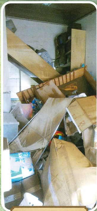
浸水の事務所
